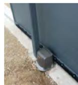
C'est la motorisation pour portail coulissant la plus utilisée. Le portail se déplace grâce au moteur sur un rail de guidage au sol. Cette motorisation nécessite un prolongateur sur le portail et un socle béton pour fixer le moteur. Elle est adaptée à tous les types de portails coulissants.
